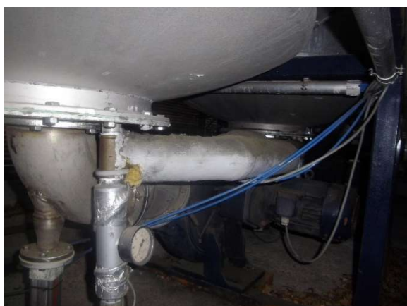
P 62: Bâtiment C - Terrasse - Machinerie absorbateur - Enveloppe de Calorifugeage Absorbateur - Photo n° 15
