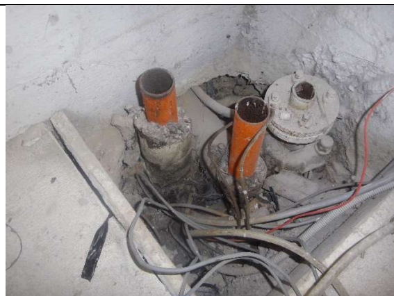
IV : Bâtiment C - R-1 - gaine technique salle propre - Conduit en Amiante ciment - Photo n° 2
