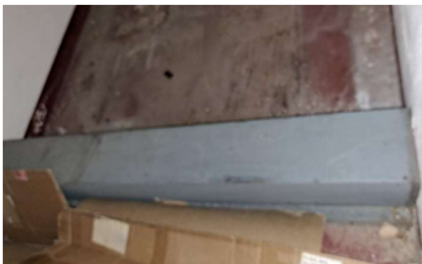
IV : Bâtiment C - R-1 - Ballon d'eau Chaude - Conduit en Amiante ciment Ventilation basse - Photo n° 11
