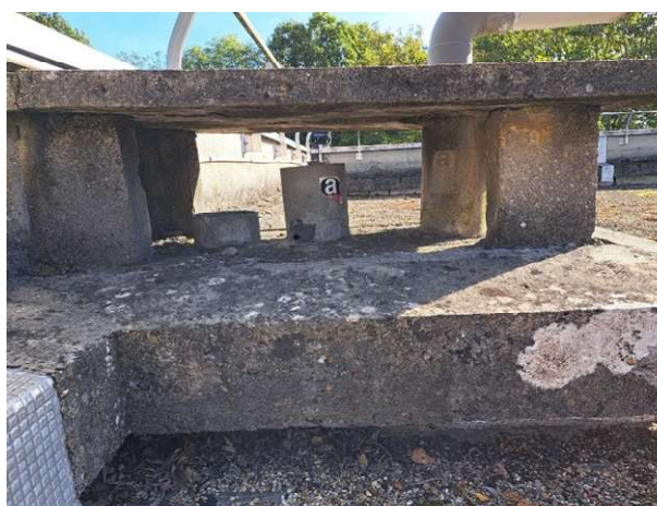
IV : Bâtiment C - Terrasse - Toiture - 3 Conduits en Amiante ciment - Photo n° 16
