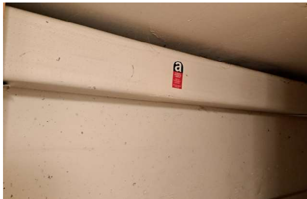
IV : Bâtiment C - R-1 - Ballon d'eau Chaude - Conduit en Amiante ciment Ventilation haute - Photo n° 10
