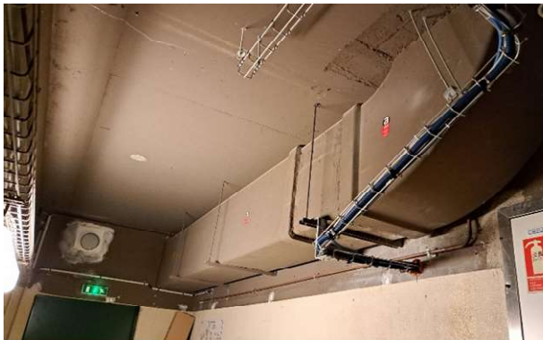
IV : Bâtiment C - R-1 - Dégagement - Conduit en Amiante ciment - Photo n° 1
