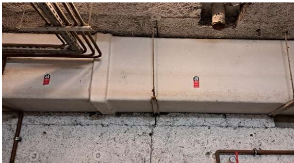
IV : Bâtiment C - R-1 - Centrale de climatisation - Conduit en Amiante ciment - Photo n° 5
