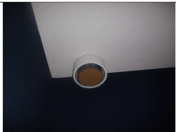
IV : Bâtiment C - RDC - Bureau C 106 - Conduit en Amiante ciment Ventilation haute - Photo n° 12
