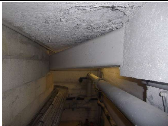
IV : Bâtiment C - R-1 - gaine technique salle propre - Conduit en Amiante ciment - Photo n° 2
