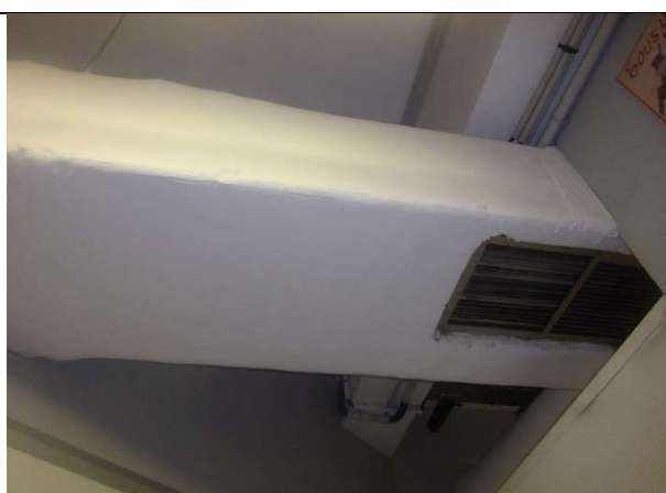
P 60: Bâtiment C - RDC - Bureau C 108 - Enveloppe de calorifugeage gaine de ventilation - Photo n° 17
